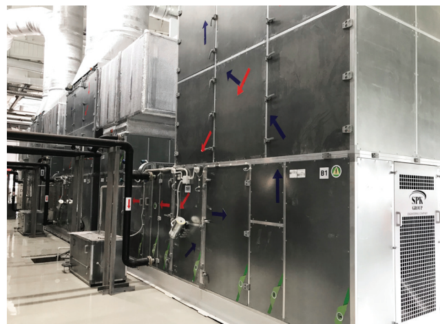
ПРИТОЧНО-ВЫТЯЖНОЙ АГРЕГАТ SPK С СИСТЕМОЙ УВЛАЖНЕНИЯ ВОЗДУХА
