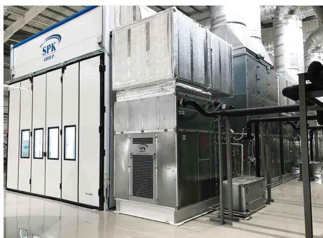
ПРИТОЧНО-ВЫТЯЖНОЙ АГРЕГАТ SPK С СИСТЕМОЙ УВЛАЖНЕНИЯ ВОЗДУХА
