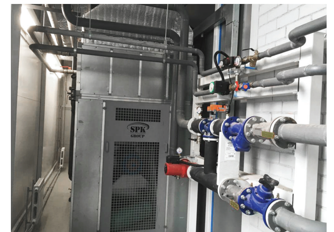
ПРИТОЧНО-ВЫТЯЖНОЙ АГРЕГАТ SPK С СИСТЕМОЙ УВЛАЖНЕНИЯ ВОЗДУХА
