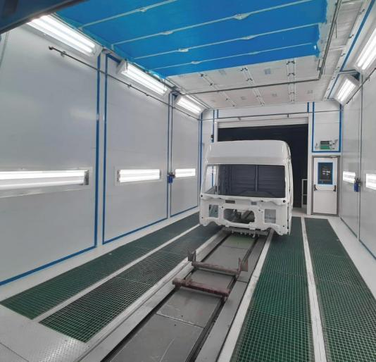
Алгоритмом работы камеры предусмотрена синхронизация действий персонала, работающего в разных секциях камеры, а также действий персонала и напольного конвейера. Предусмотрены блокировки, препятствующие перемещению конвейером кабина до окончания технологических операций. Каждая секция оснащена собственной автоматической установкой порошкового пожаротушения.
