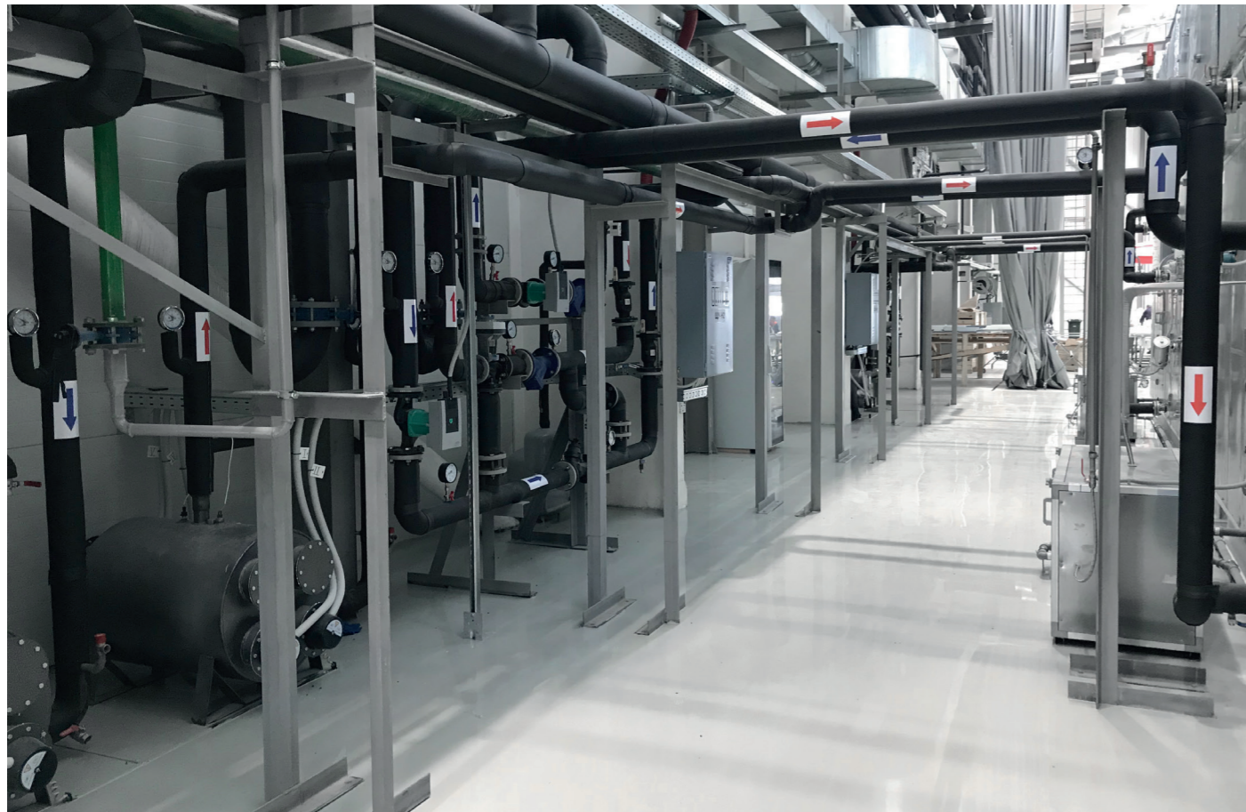
Узел управления системы теплоснабжения водяного теплообменника для нагрева приточного воздуха
