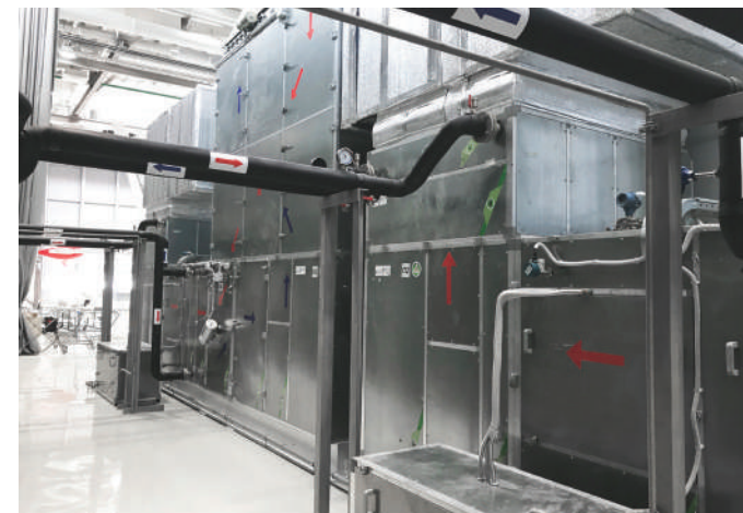
Приточно-вытяжной агрегат SPK с системой увлажнения воздуха
