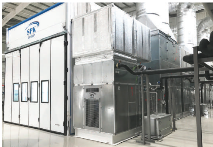
Приточно-вытяжной агрегат SPK с системой увлажнения воздуха
