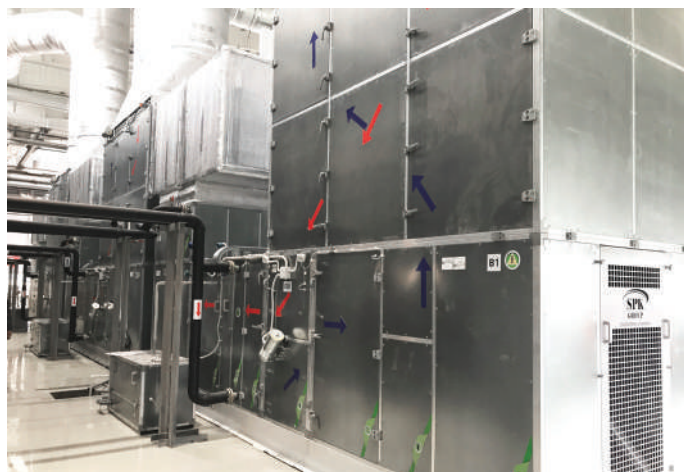
Приточно-вытяжной агрегат SPK с системой увлажнения воздуха
