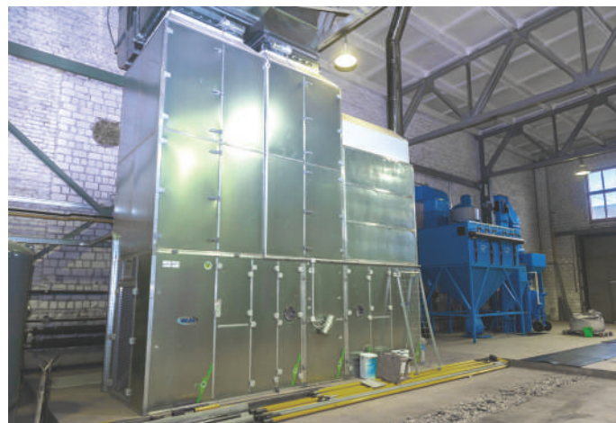
Приточно-вытяжной агрегат SPK со встроенным рекуператором (взрывозащищенное исполнение)
